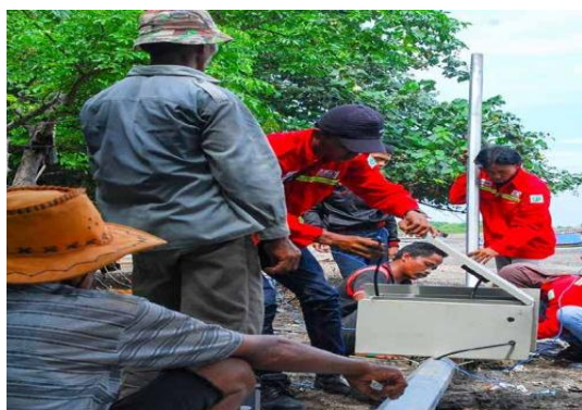
Pemasangan Lampu jalan (Poltovoltaic)
