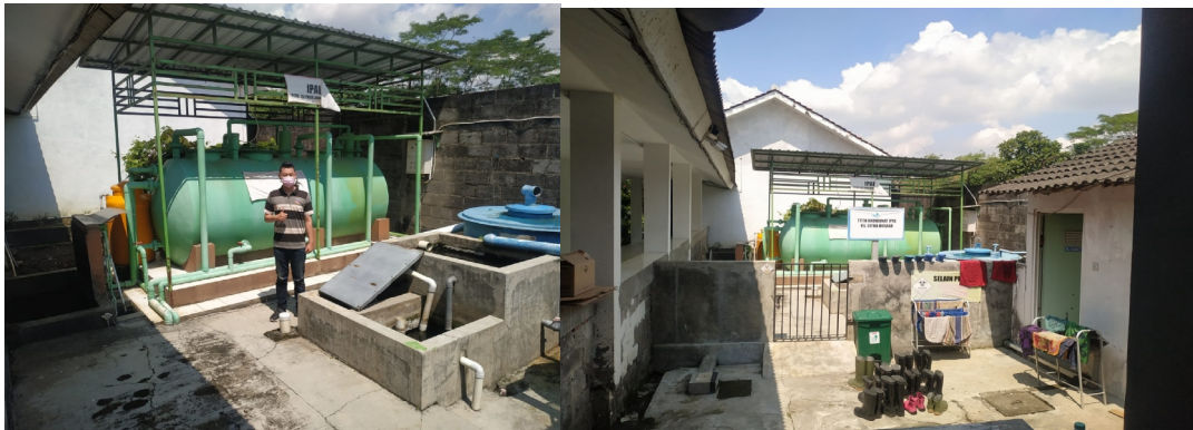
Orientasi Lapangan selesai Wawancara Dg Akhmad Ponaji (Bagian Instalansi Sanitasi) RS Citra Husada Jember
